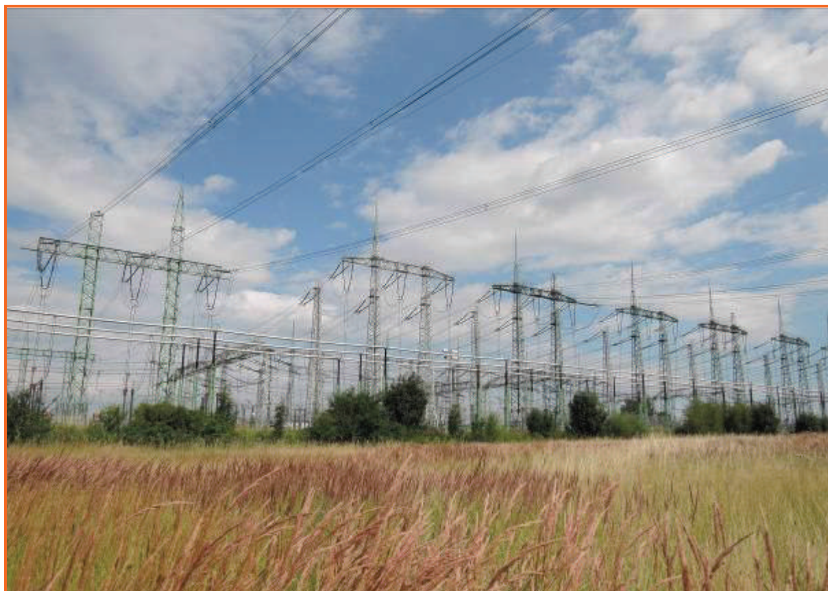
Obrázek č. 18: Transformační stanice v Nošovicích 61
